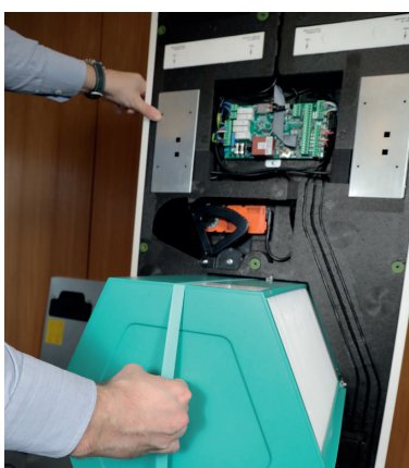
3. Démontér veksler ved at hive forsigtigt i remmen.
