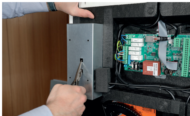
4. Démontér ventilatorhus (evt. med indbygget forvarme-flade) ved at trække forsigtigt i ventilatorhuset med en tang.
