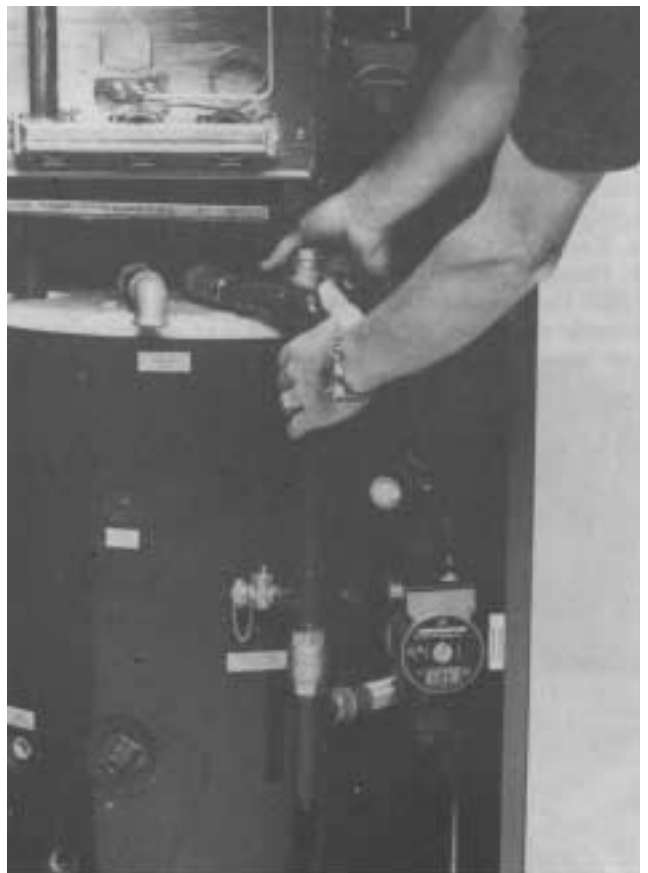
3.2.6.: Montering af rørsektion. Rørsektion med pumpe 2 og shunt monteres som vist. (Vær opmærksom på at flexible slanger ikke vrides og knækkes under montagen!).
