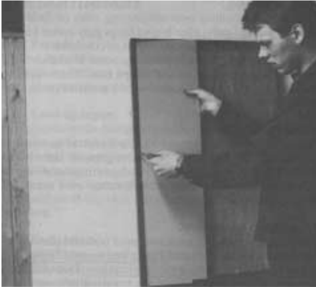
3.2.2.: Montering af indvendig sideplade.
