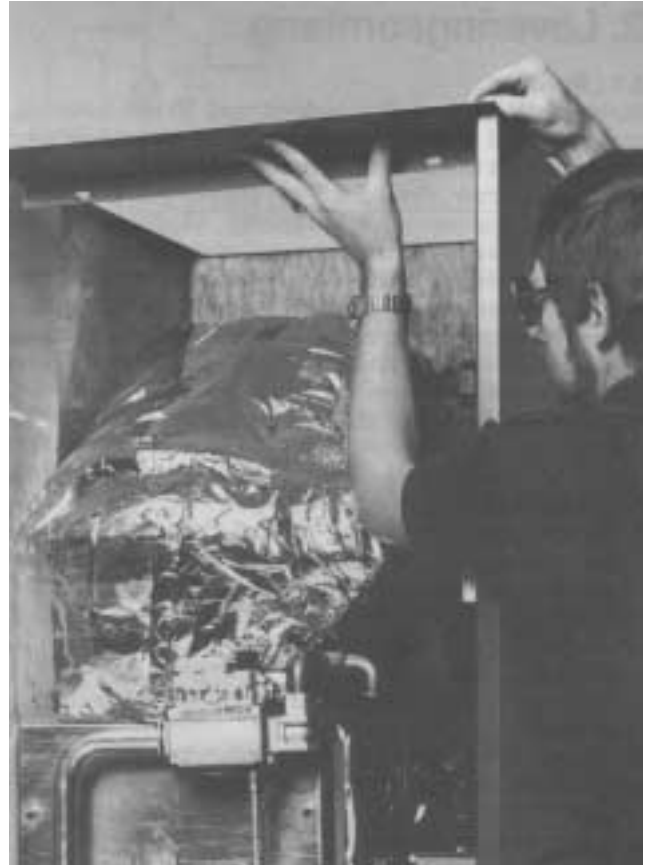
3.2.5.: Montering af toplade. Topplade monteres som vist.
